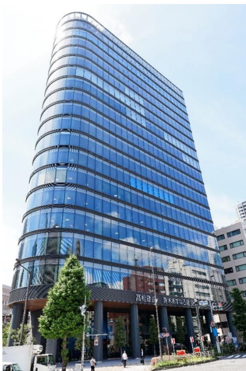
CFT 構造賞(普及)を受賞した 高松コンストラクショングループ東京本社ビル
