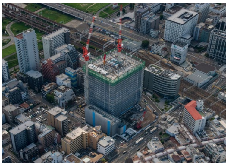
施工中の様子
