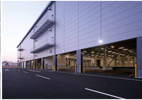
北側トラックバース
