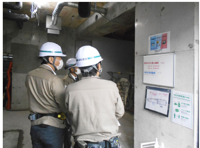
安全通路に関する掲示を確認する高松社長（左）
