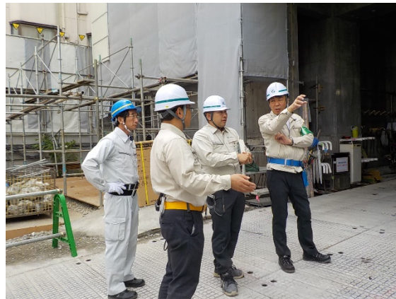
タワークレーン揚重の危険回避について打合せする高松社長（右）
