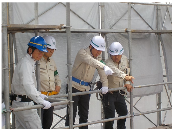
建込階にて資機材の整理方法を点検する高松社長（右から2番目）
