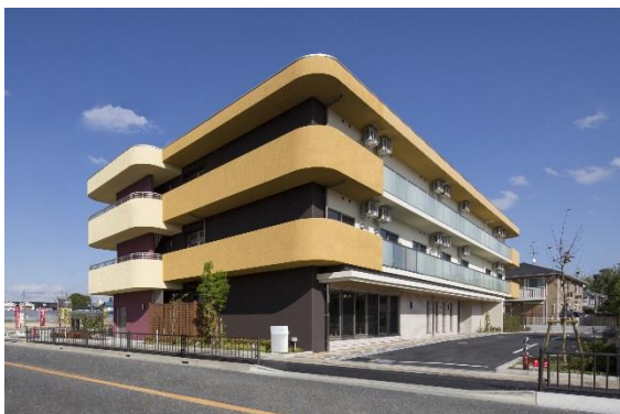
エニシエ川西加茂 外観写真
