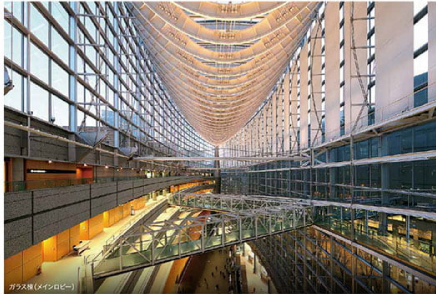
ガラス棟(メインロビー)
