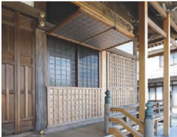
格子を組み付けた板戸を吊り上げて開閉する、郡戸(しとみど)。平安時代の住宅建築で使われ始め、やがて寺社にも広まっていた。
