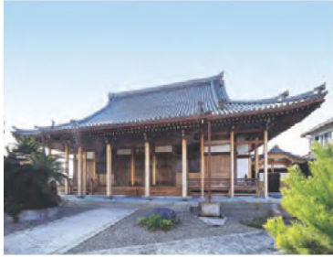
解体後、修復しながら組み直された本堂。屋根を支える向拝柱(こはいばしら)が4本もあるのは、この規模の寺院では珍しい。
