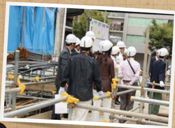
基礎配筋工事
